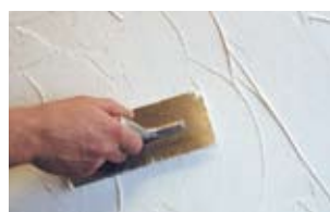
Нанесение шпателем
