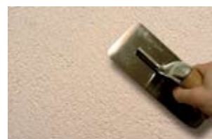
Нанесение финишного слоя
