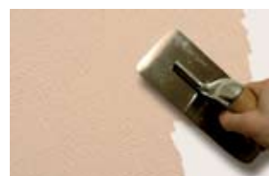
Нанесение базового слоя
