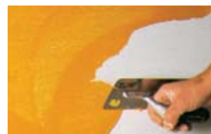
Нанесение базового слоя
