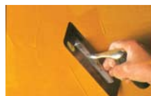
Нанесение финишного слоя
