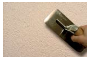
Нанесение финишного слоя
