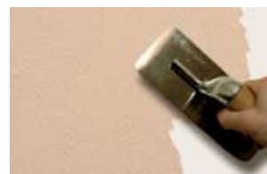
Нанесение базового слоя
