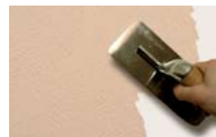
Нанесение базового слоя
