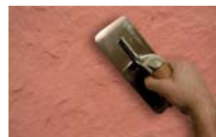
Нанесение шпателем
