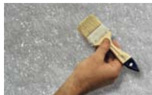
Нанесение Accent кистью в два слоя
