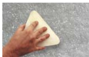
Растянуть белые частички пластиковым шпателем
